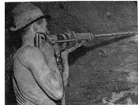
Abb. 18. Anbringen eines Bohrloches in Schulterhöhe.
