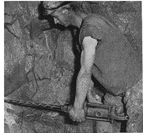
Abb. 17. Andrücken des Bohrhammers mit dem Oberschenkel.
